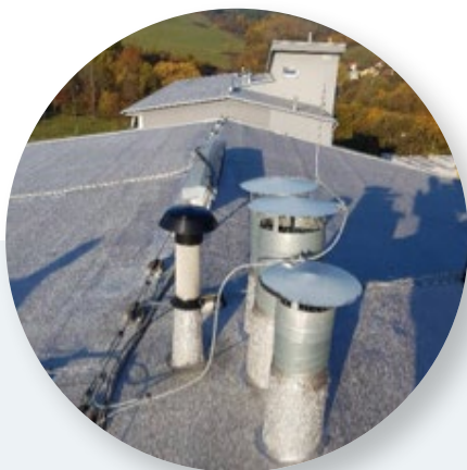
Rekonštrukcia strešného plášťa, odvetrania a zníženie teploty v podkrovných bytoch
